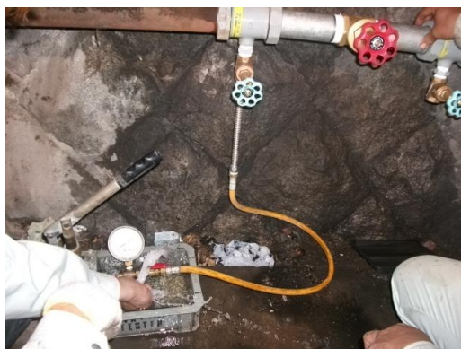
B区域漏水テスト
