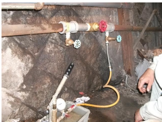
A区域漏水テスト
